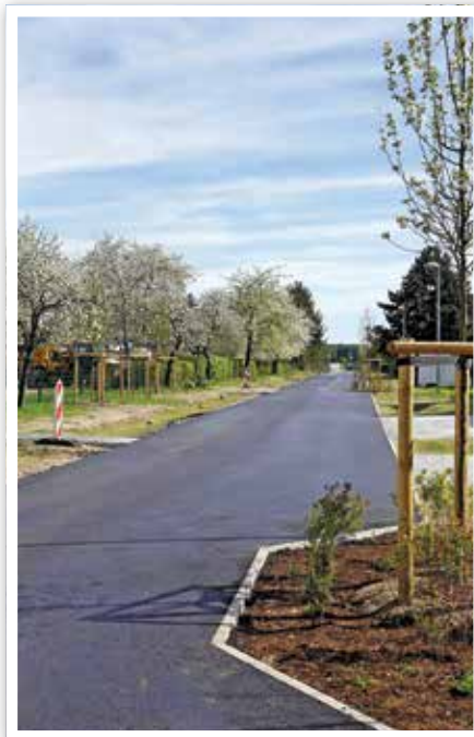
Der „Gottsdorfer Weg“ in Züllichendorf nach dem Aufbringen der ca. 1.150 Quadratmeter Schwarzdecke
