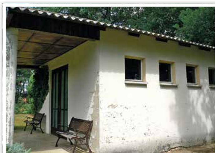
Die Trauerhalle vor der Sanierung
