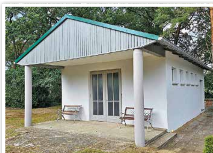
Die Trauerhalle auf dem Liebätzer Friedhof ist nach der Sanierung kaum wiederzuerkennen.
