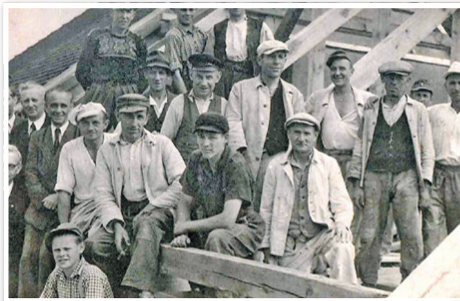
Arbeiter der Firma Münnich bei der Aufstockung der Schule Woltersdorf 1952 evtl. beim Richtfest, da auch Vertreter des Schulamtes zu sehen sind.
