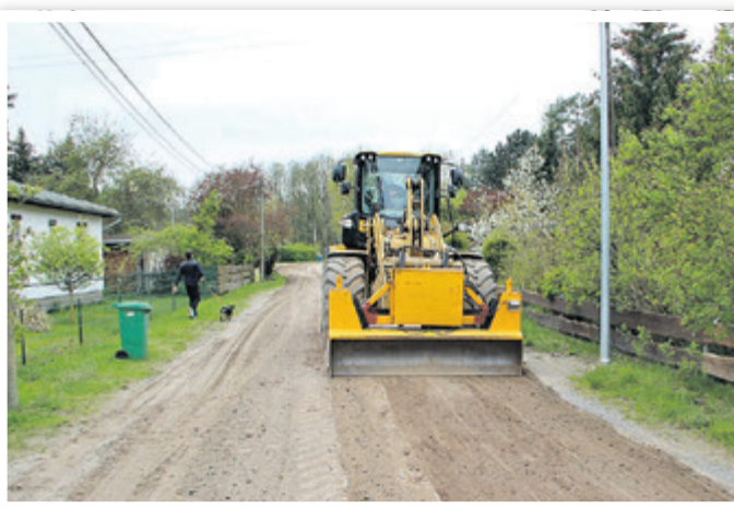
Mit Hilfe schwerer Technik wurde der Weg „Am Stabelsee“ planiert.
